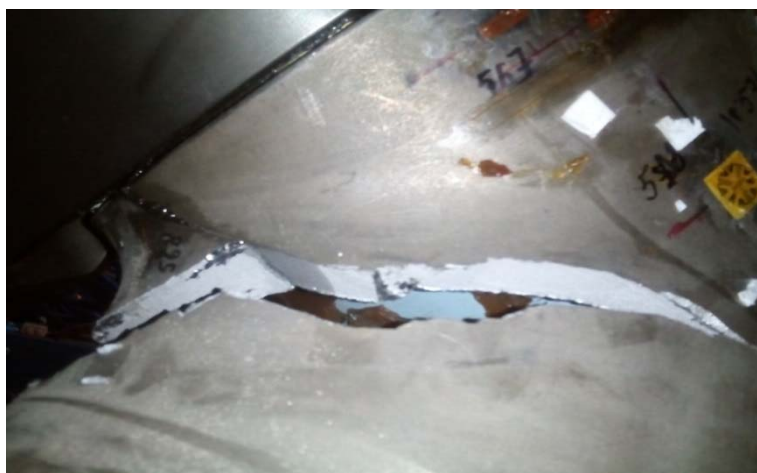
Рис. 2. Место зарождения и роста усталостной трещины в траверсе
