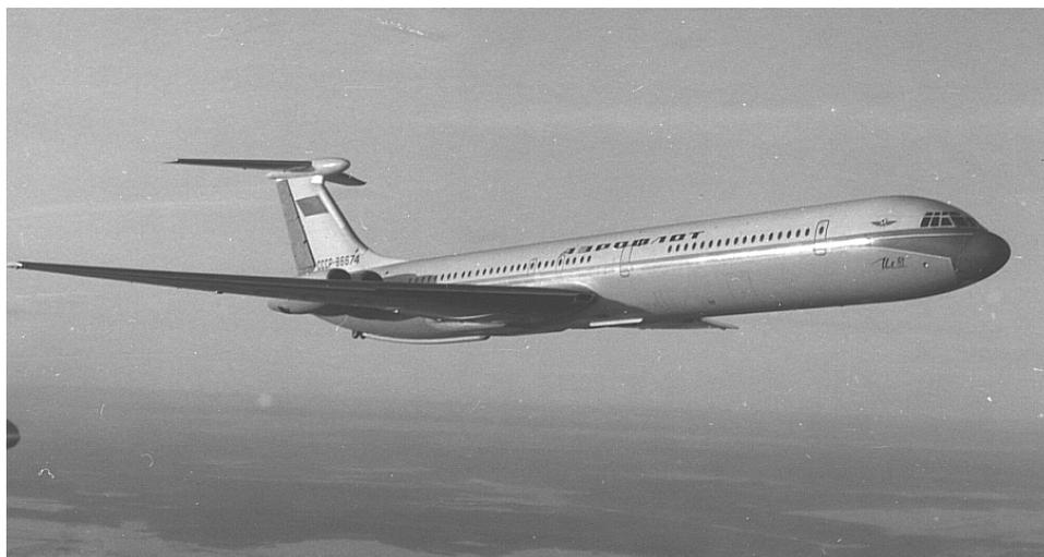
Рис. 3. Дальний магистральный пассажирский самолёт Ил-62 с реактивными двигателями НК-8-4
