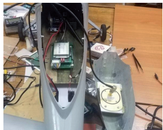
Рисунок 6 – Аппаратный блок, установленный в корпус перед монтажом основной системы управления БПЛА
